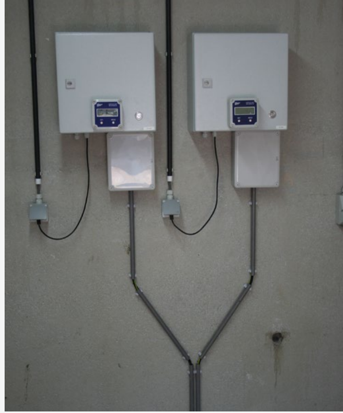
Ces boîtes de commutation convertissent la tension de 230 volts du secteur en 7000 ou 8000 volts
