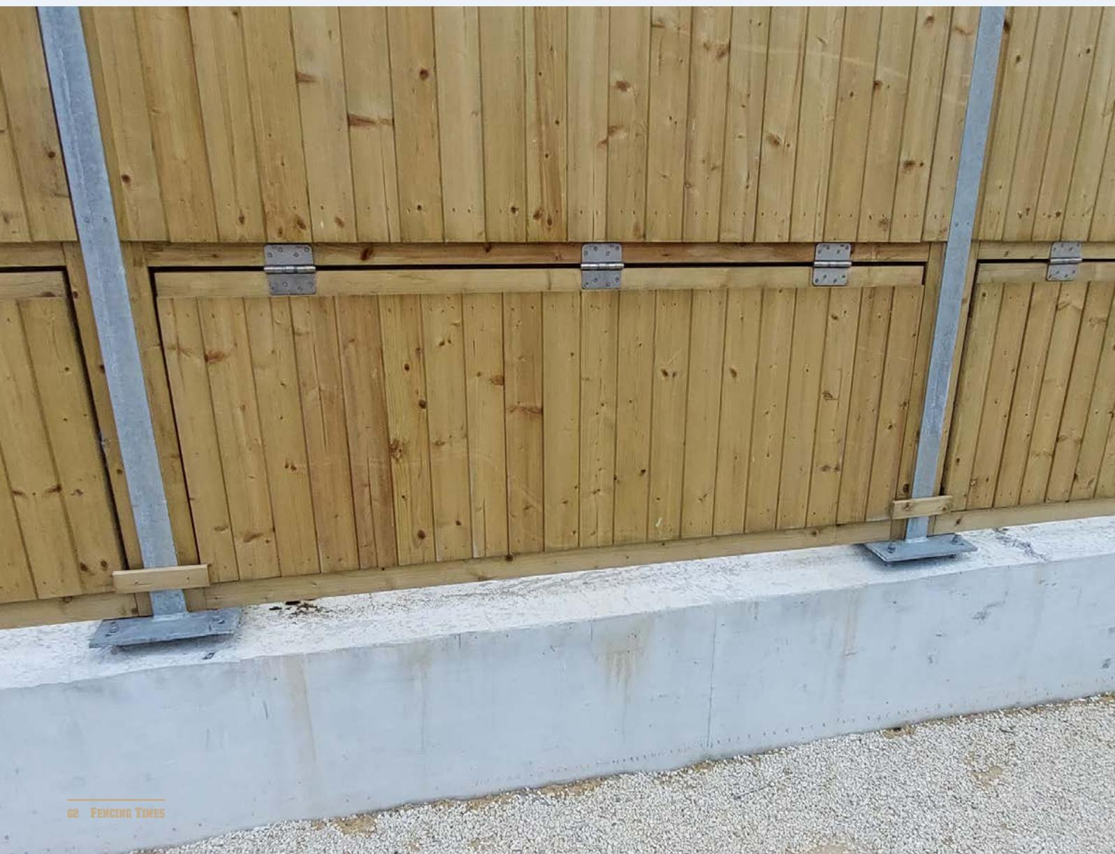
Les petits blocs se détachent si la pression de l'eau à l'extérieur devient trop importante. Pour que la clôture conserve sa fonction de sécurité périmétrique, un panneau de clôture est monté à l'extérieur, ce qui empêche les panneaux articulés d'être ouverts de l'extérieur.
