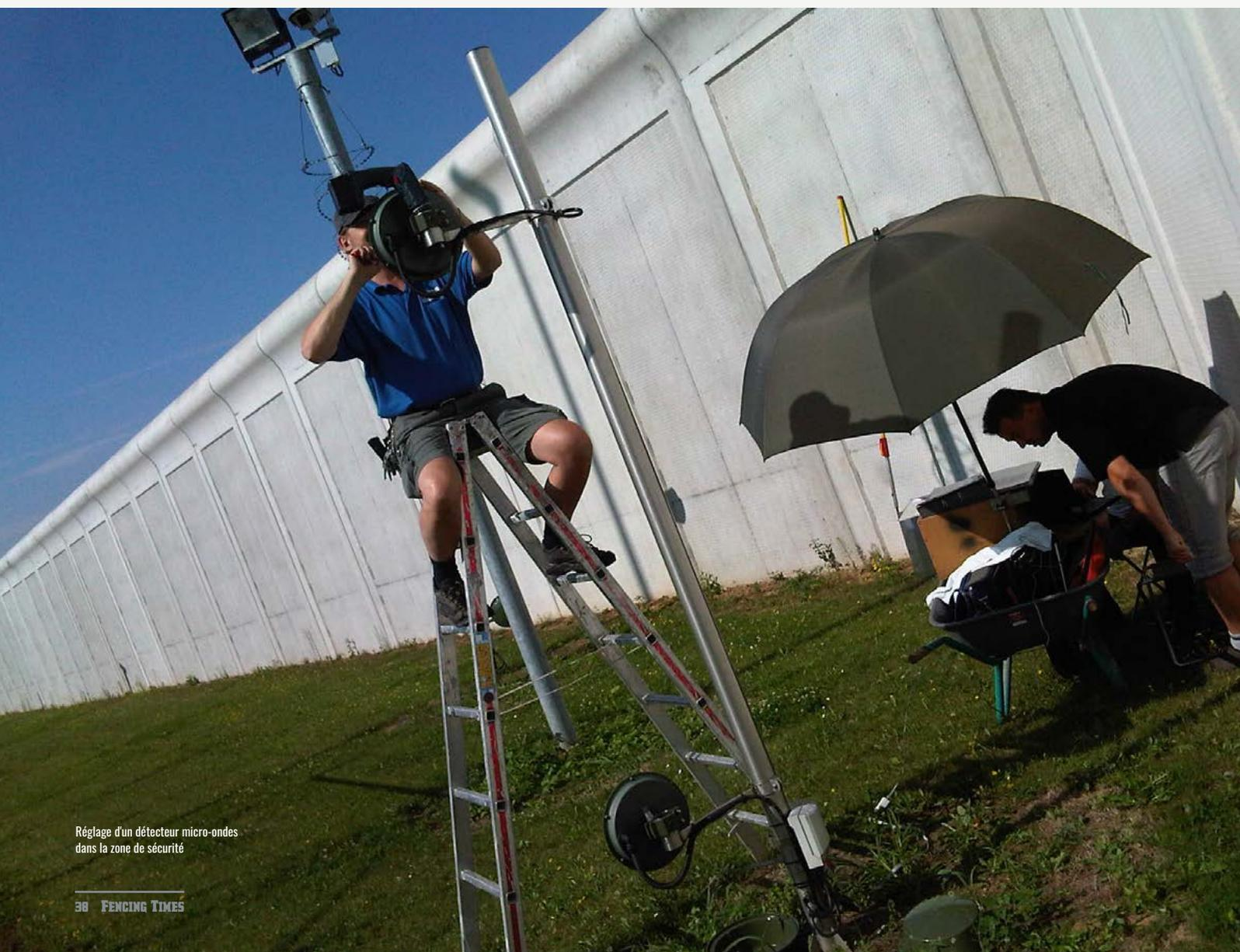
Réglage d'un détecteur micro-ondes dans la zone de sécurité
