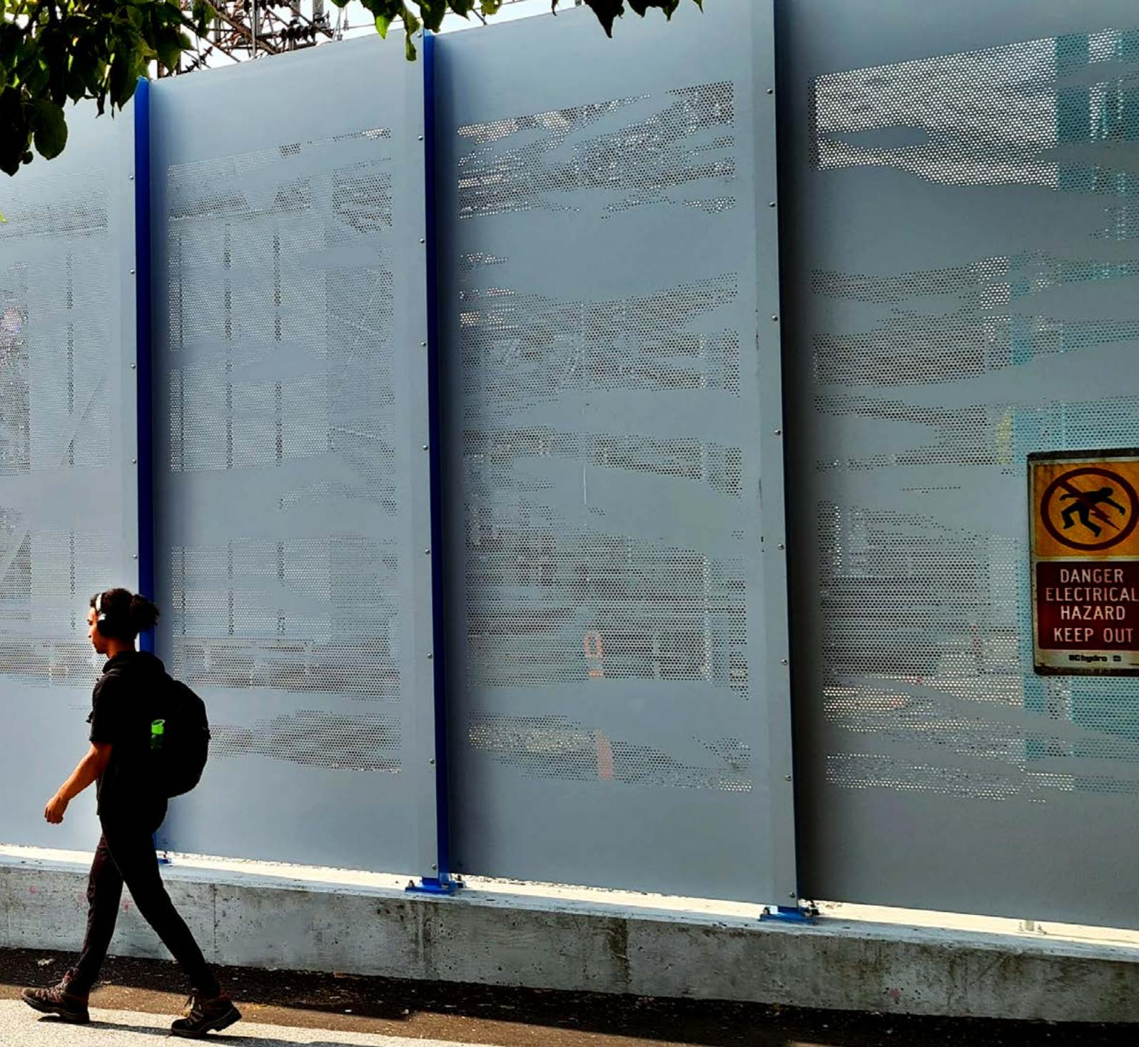
Zaun, un fabricant britannique de clôtures de Wolverhampton, près de Birmingham, lance un nouveau type de clôtures. Il s'agit de Picture Perf, dont le remplissage est constitué de tôles perforées en acier inoxydable ou en aluminium, les perforations formant une image.
